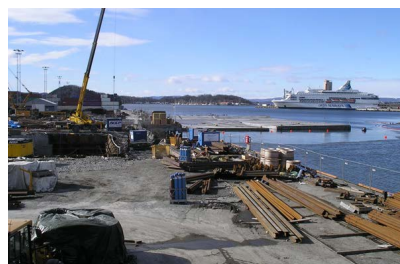
Bjørvikatunnel Oslo | Norway
