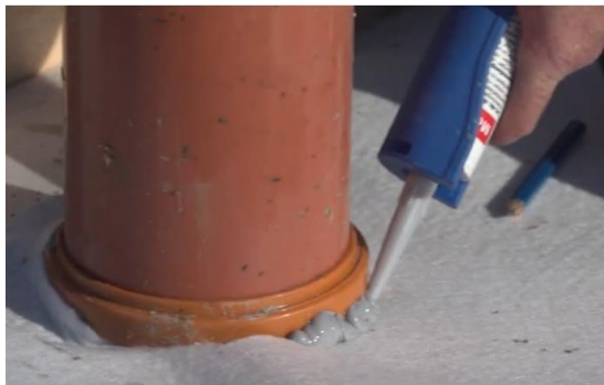
CEM805-massaa levitetään putken ympärille.
