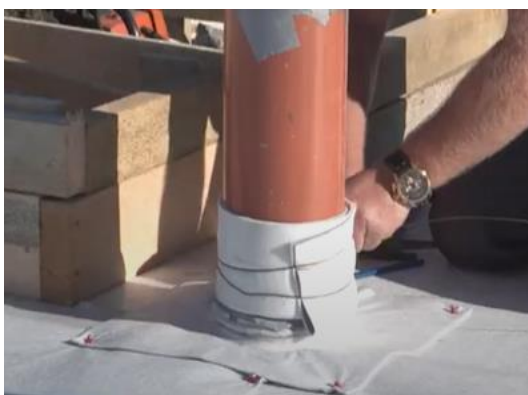
Pala kiinnitetään vielä lisäksi esim. teräslangalla.
