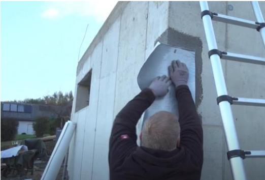
Massalla kiinnitetään kulmapalat SilverSeal kalvosta.
