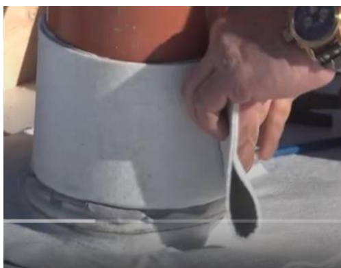
Putken ympärille painetaan siihen sopivaksi leikattu SilverSeal kalvon pala kaksin kerroin
