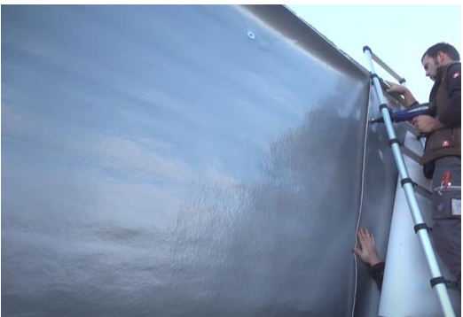
Sauma kiinnitetään lisäksi myös mekaanisesti.
