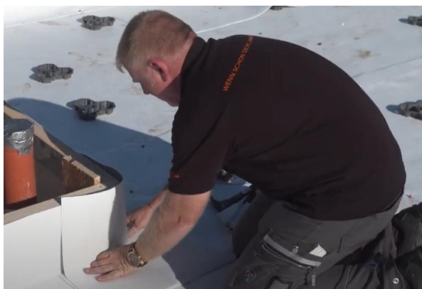
Leikattu SilverSeal kalvon pala painetaan hyvin CEM805 -massan päälle.
