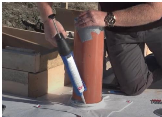
Avoimeen saumakohtaan levitetään CEM805 -massaa.
