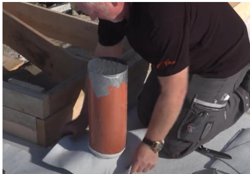
Putken ympärille painetaan siihen sopivaksi leikattu SilverSeal kalvon pala.
