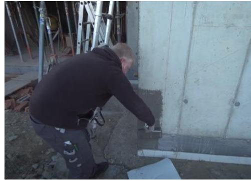
Kulma alueille levitetään esim. telalla CEMstar massaa kauttaaltaan.
