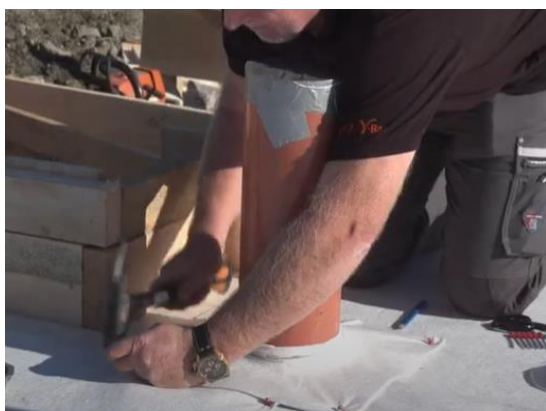
Kappale kiinnitetään naulaamalla.
