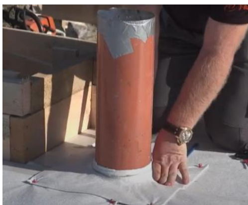
Kiinnitys varmistetaan vielä painelemalla käsin.
