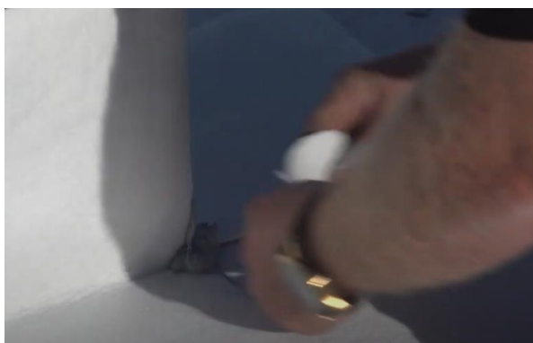
Paikkaa pienetkin kolot ja saumat kiinnittämällä CEM805 -massalla SilverSealista tehdyllä paikalla.
