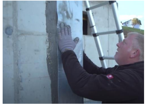
Kulmapalat painetaan huolellisesti paikalleen.
