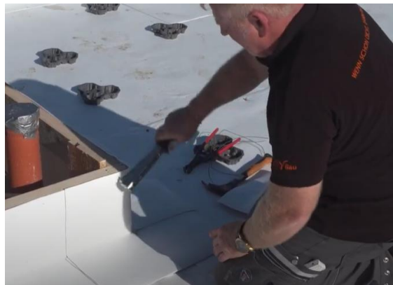
Pystypinnat kiinnitetään vielä mekaanisesti nitojalla.
