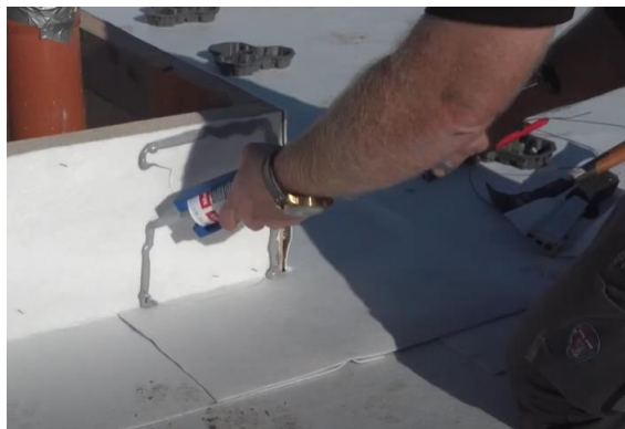
CEM805 -massaa levitetään kulman alueelle.
