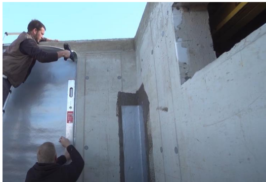
SilverSeal kalvo kiinnitetään seinään mekaanisesti naulaamalla.
