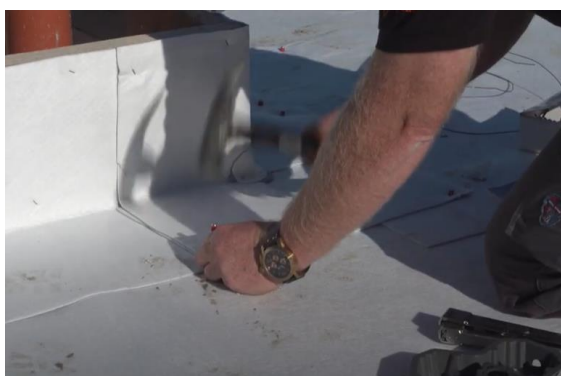
Vaakapinnat naulataan kiinni.
