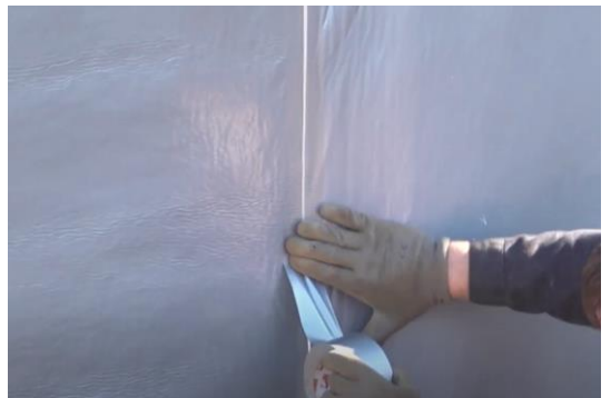
...ja teipataan vielä varmistuksena umpeen.
