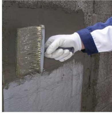
CEMstar voidaan levittää harjaamalla
