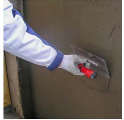
CEMstar voidaan levittää lastalla
